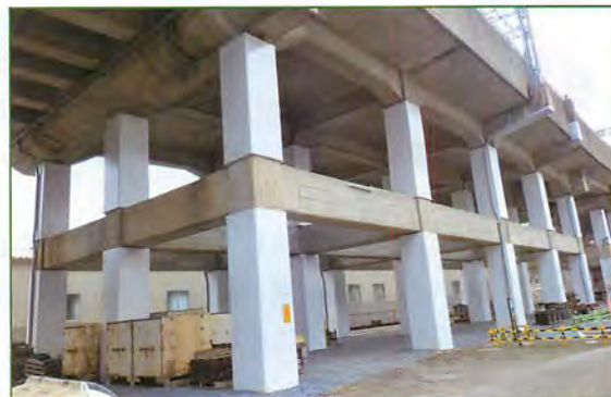
高架橋柱耐震補強
