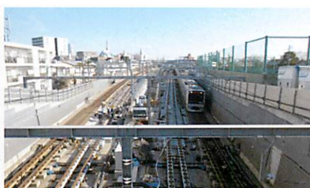
代々木上原～東北沢間の地上部の工事の様子
