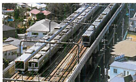
完成区間の経堂～千歳船橋間
