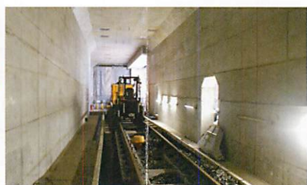
東北沢～下北沢間のトンネル工事の様子
